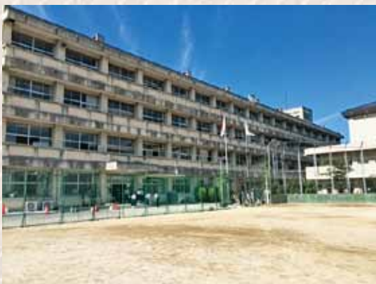
校舎の耐震補強工事を行う西条中学校
