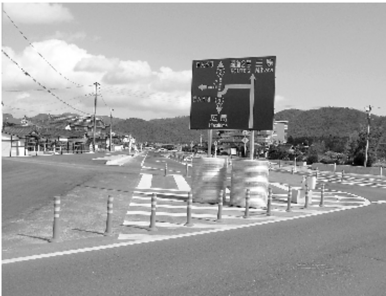
▲ 暫定二車線で供用されている国道375号バイパス
