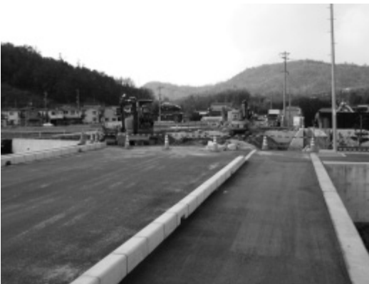
工事が進む都市計画道路飯田線
