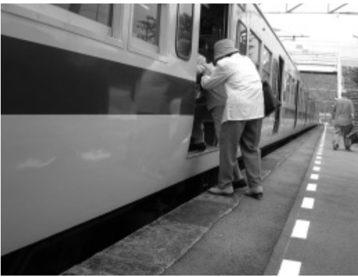
入野駅のホームの段差の状況
