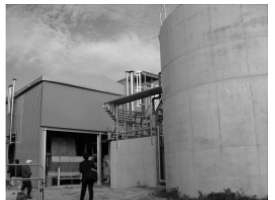
バイオマスを効率的にエネルギー化する広島大学の施設
