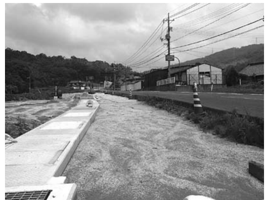
改良工事中の国道375号杵原バイパス
