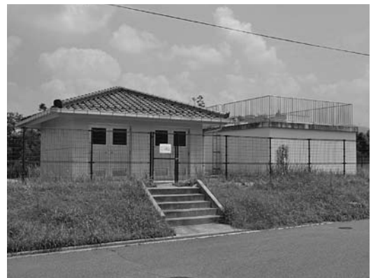
福富簡易水道のタンク
