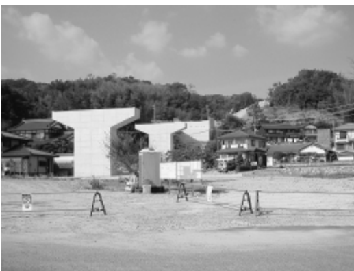
都市計画道路上条浜田線の改良工事
