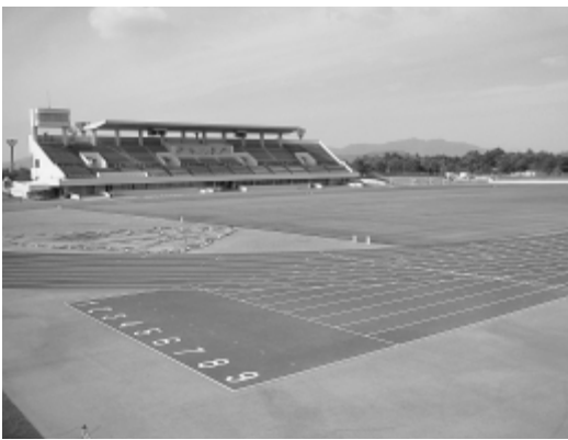
夜間照明が設置されていない東広島運動公園陸上競技場
