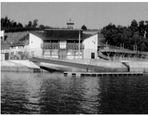
コンクリート製に改良された龍王島の浮き桟橋
