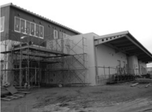
建設が進む仮称「東広島学校給食センター」
