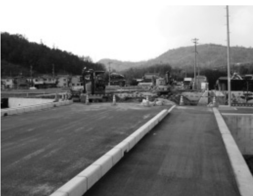
工事が進む都市計画道路飯田線
