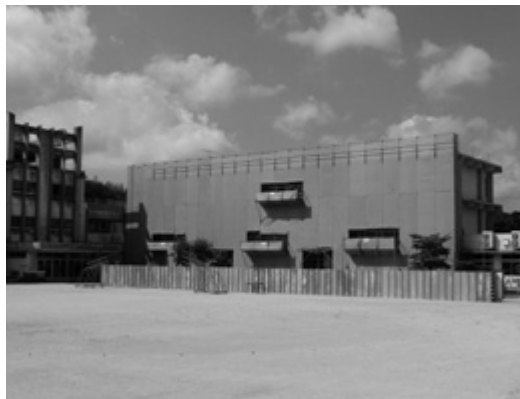
耐震補強工事が行われている造賀小学校
