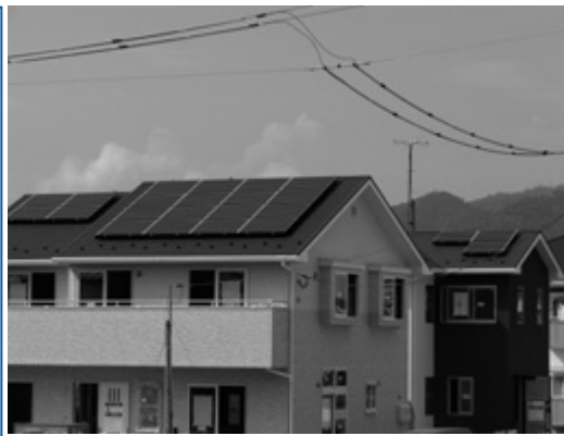
ソーラーパネルが設置された住宅
