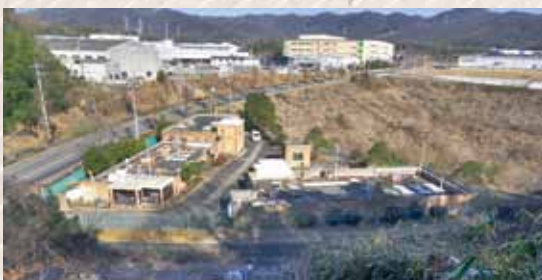
中核工業団地汚水処理施設
