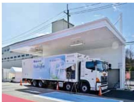
志和流通団地内に設置された水素ステーション
