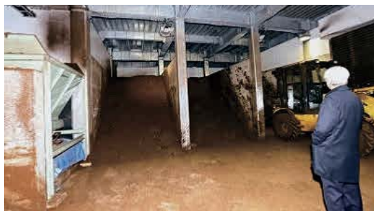
東御市生ごみリサイクル施設 「エコクリーンとうみ」二次発酵槽
