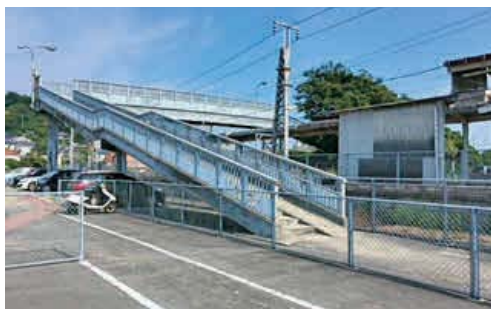
マリナーアーチ (安芸津駅舎と安芸津港とを結ぶ跨線橋)
