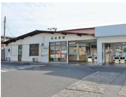
橋上化が予定されている西高屋駅
