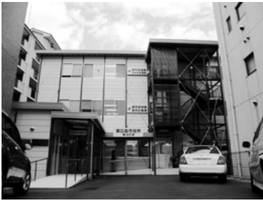
新たに建設された市役所第3庁舎
