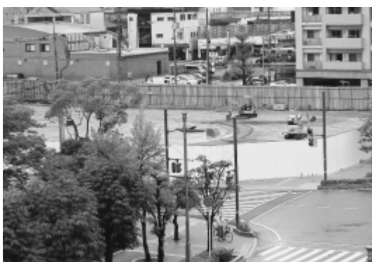
市民ホール建設予定地
