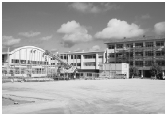
耐震化工事中の高屋西小学校
