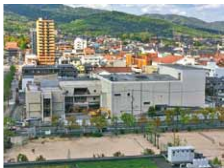
解体の始まった中央生涯学習センター
