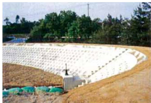
整備中のため池
