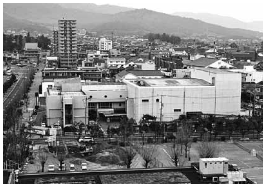
老朽化が進む中央生涯学習センター
