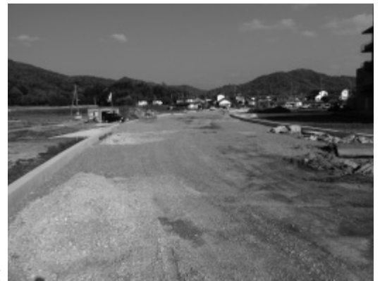
建設中の西条中央巡回線(助実工区)
