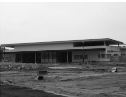
建設中の道の駅「湖畔の里福富」
