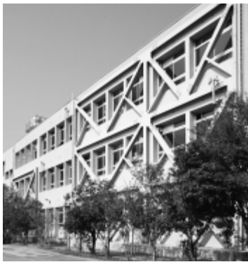
耐震補強された中学校
