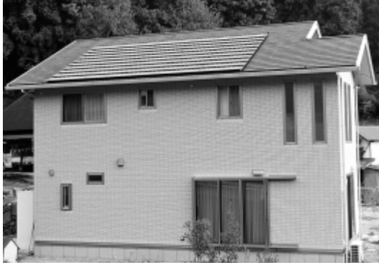
太陽光パネルを設置した住宅
