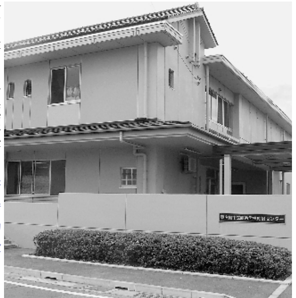
▲ 西条学校給食センター
