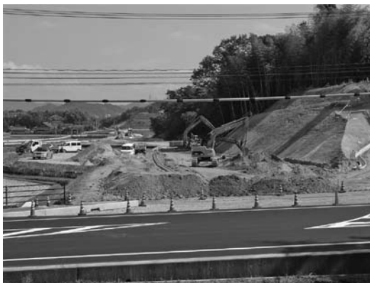
道路の建設工事現場
