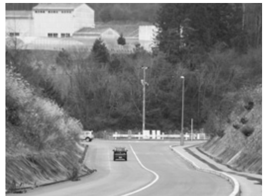
国道375号福富バイパス（瀬野川福富本郷線付近）
