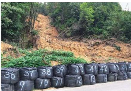
土砂が線路に達した崩壊箇所。土嚢で応急処置している。
