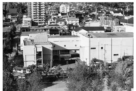
老朽化が進む公共施設
