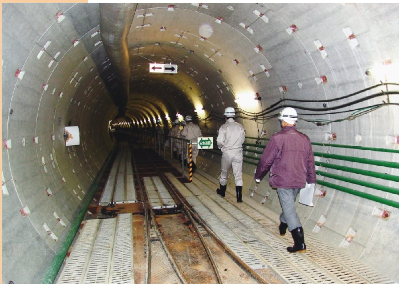
西条1号雨水幹線 管きよ内
