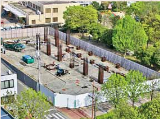
ホテルを建設する予定だったが、リーマンショックによる景気の悪化により、建設工事が中断していた。
