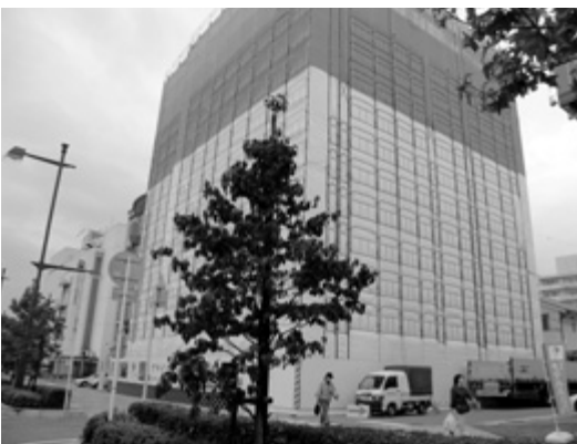
西条中学校区で建設が進む分譲マンション
