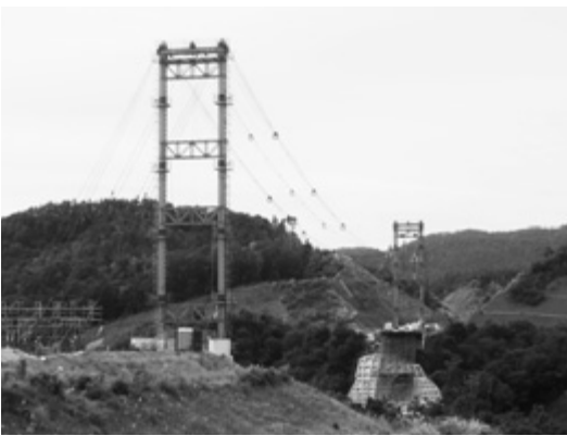
建設中の国道375号福富バイパス（しゃくなげ大橋）
