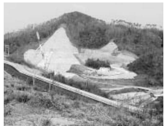
福富ダム建設工事
