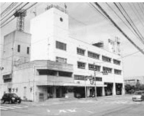
老朽化する消防庁舎
