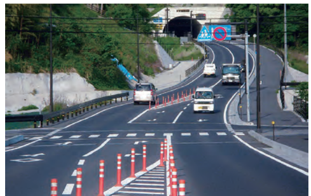
国道185号安芸津バイパス
