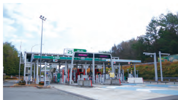
河内インターチェンジ
