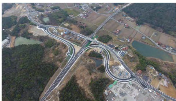
大多田インターチェンジ
