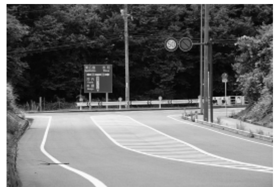
国道375号福富バイパス
