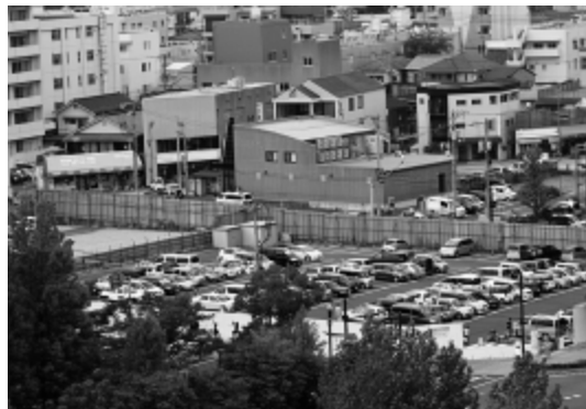
新庁舎から見る市民ホール建設予定地
