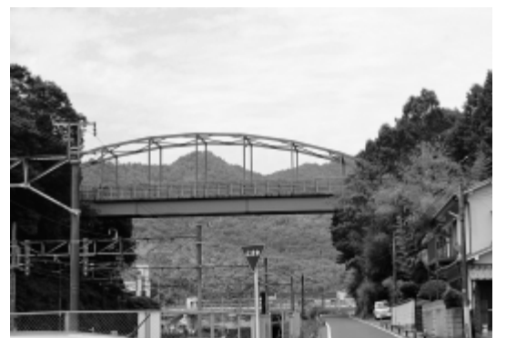
八本松駅付近の跨道橋
