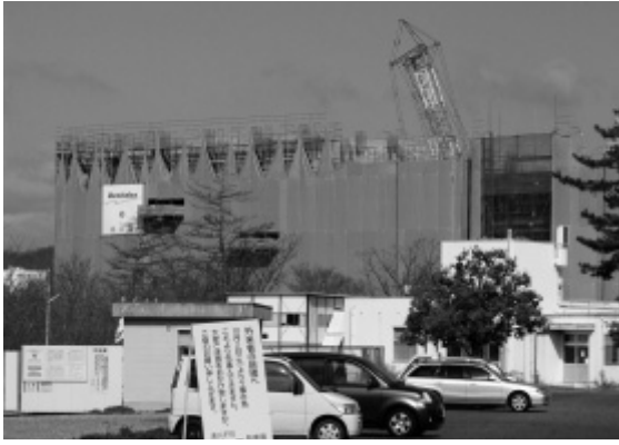
建て替え中の東広島医療センターの病棟
