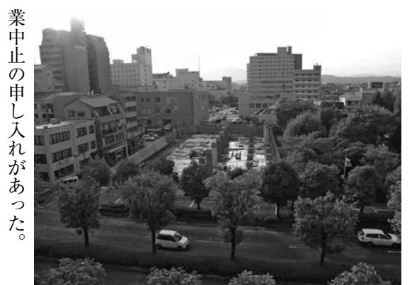
工事が中断した仮称「東広島ホテル」建設予定地
