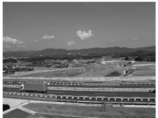
建設中の東広島呉道路（手前は山陽自動車道）
