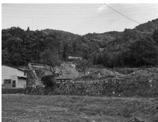
7月発生の豪雨災害現場
