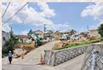
西条駅北第2駐輪場 (工事中)
