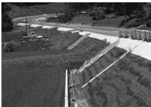
土羽仕上げの法面
