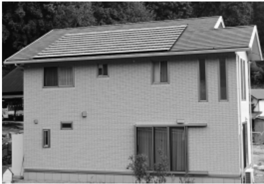
太陽光発電システムを設置した住宅
