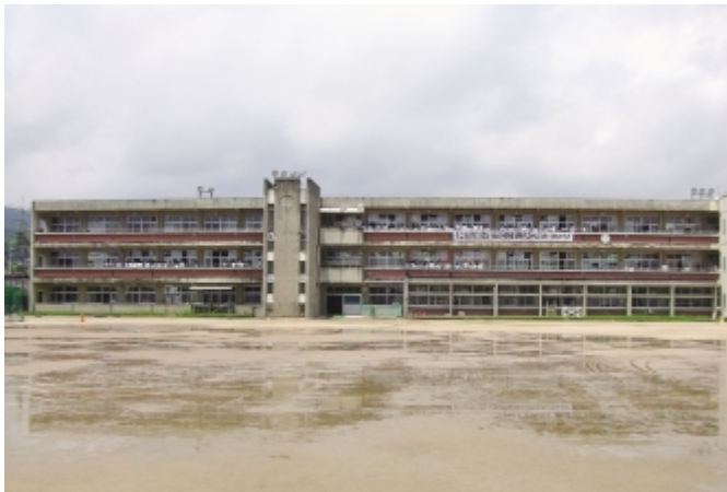
安芸津中学校旧校舎
