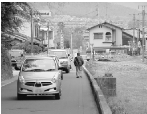
JR八本松駅北口付近の歩道未整備区間
