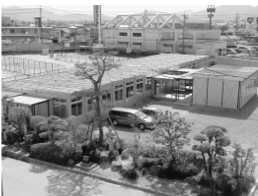
西条中学校に設置されたプレハブ教室
