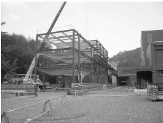
本年7月に本稼動するペットボトル等処理施設の建設現場
