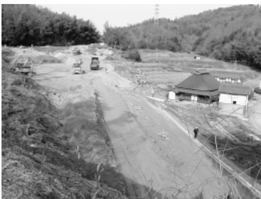
国道375号杵原地区の改良工事
