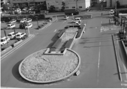
市庁舎建設工事にとりかかった予定地
