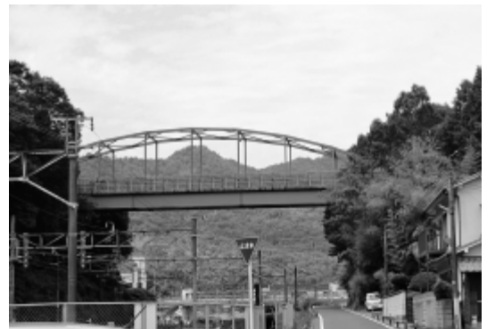
八本松駅付近の跨道橋
