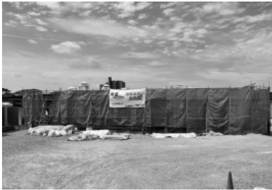
建設中の民間の保育所
