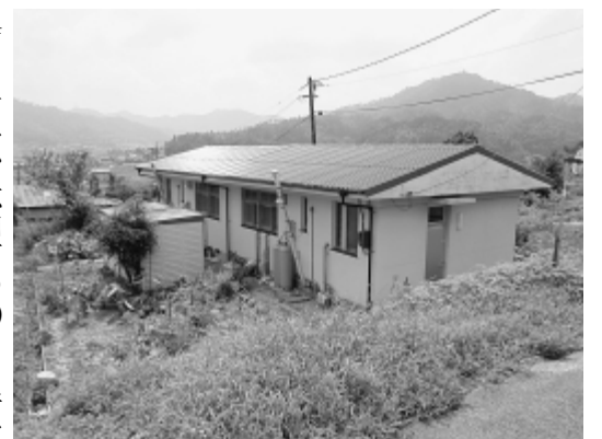
志和町の市営免山住宅
