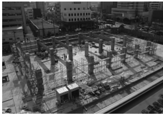
建設中の新庁舎
