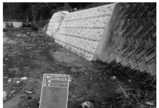
災害復旧現場
