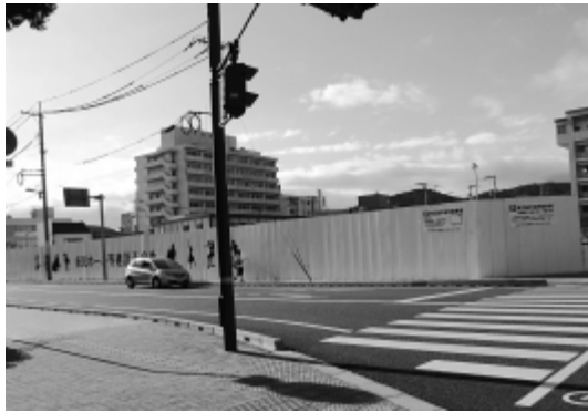
市民ホール建設予定地
