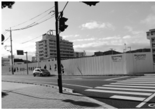
市民ホール建設予定地
