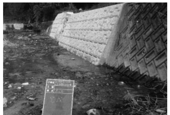
災害復旧現場
