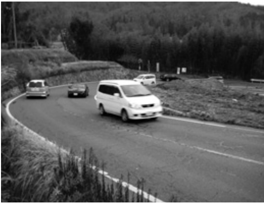
杵原地区の国道375号のS字カーブ
