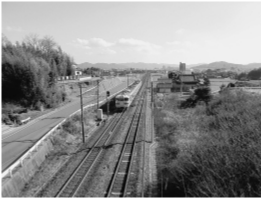
（仮称）寺家新駅設置予定地付近
