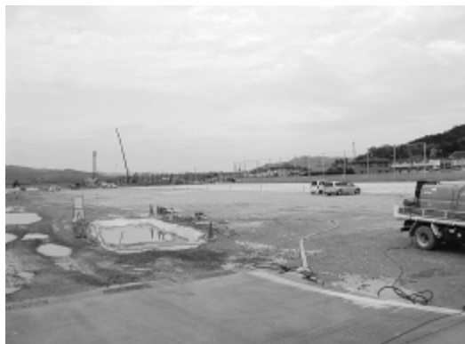
建設が進む中央中学校
