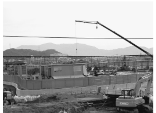
建設中の中央中学校
