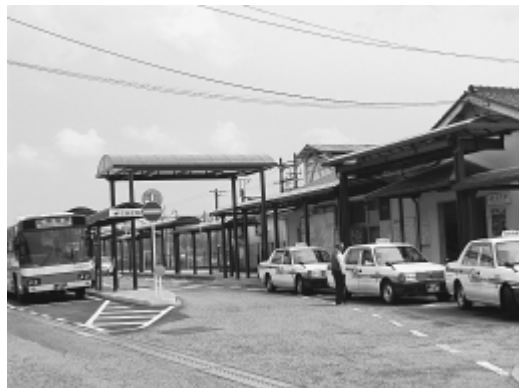
整備が完了した白市駅前広場
