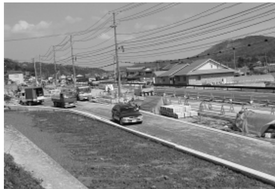
4車線化工事が行われている国道2号 西条バイパス
