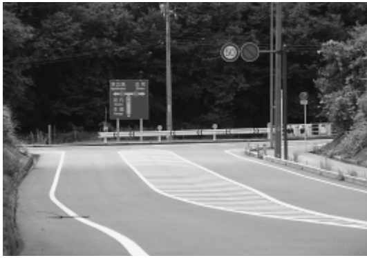
国道375号福富バイパス
