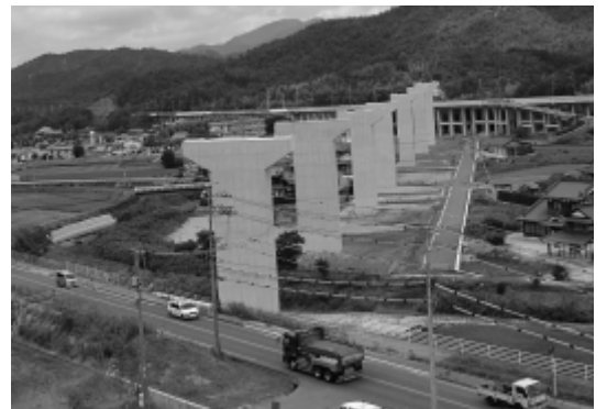
建設が進む東広島・呉自動車道
