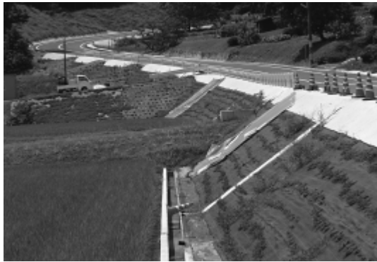
土羽仕上げの法面
