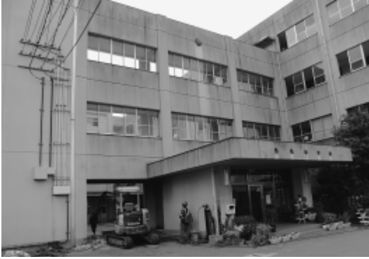
今年度耐震工を行う西条中学校
