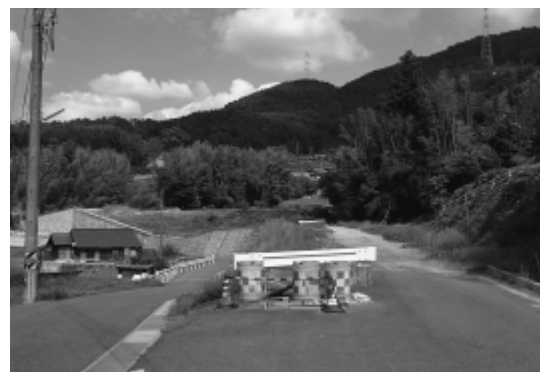
主要地方道東広島向原線
