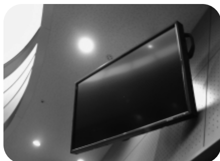
○議場モニター：議場に設置された3台のカメラ映像と、新たに導入した押しボタンによる採決システムで採決状況等を表示
