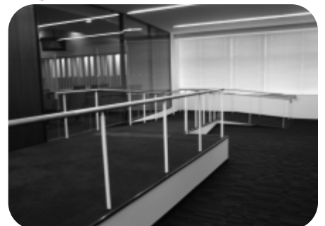
○バリアフリー化された傍聴者入口と傍聴席：スロープを設置した傍聴者用入口と車椅子用傍聴席を設置
