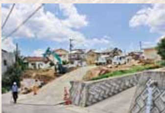
西条駅北第2駐輪場 (工事中)
