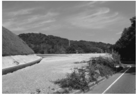
国道375号杵原付近
