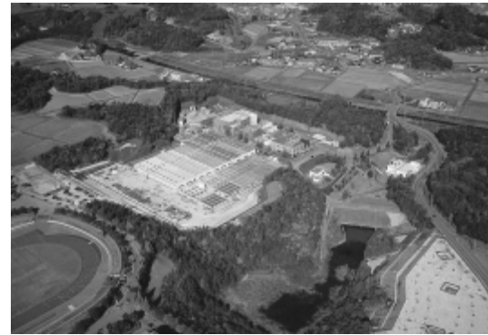
東広島浄化センター
