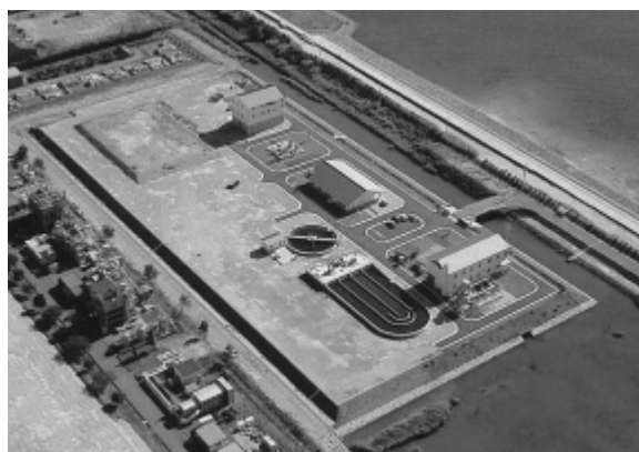
安芸津浄化センター
