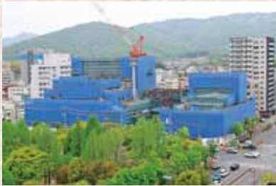
建設中の市民ホール「くらら」
